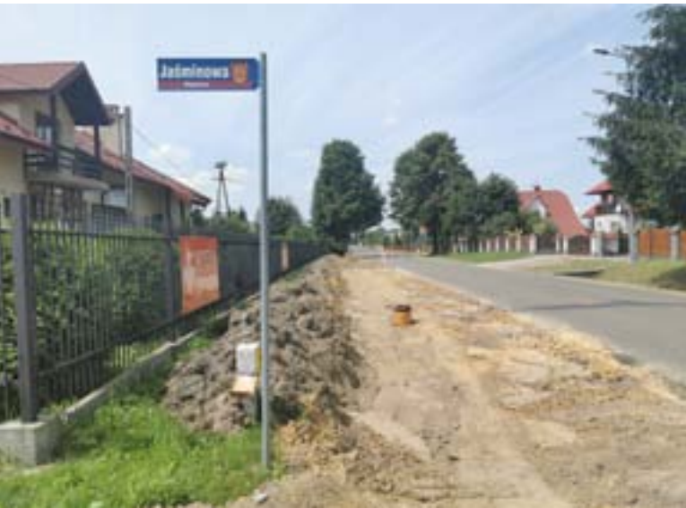
Przebudowa drogi w Wiązownicy.
