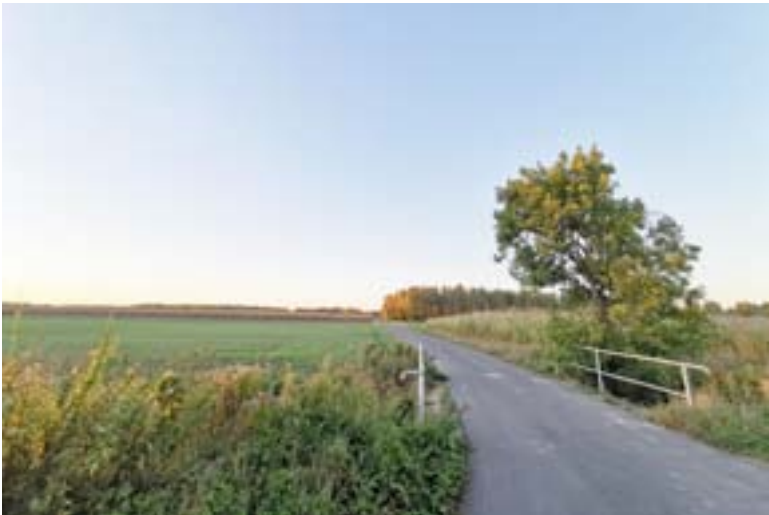
Jedna z dwóch nowych dróg, wybudowanych od podstaw w tym roku.
