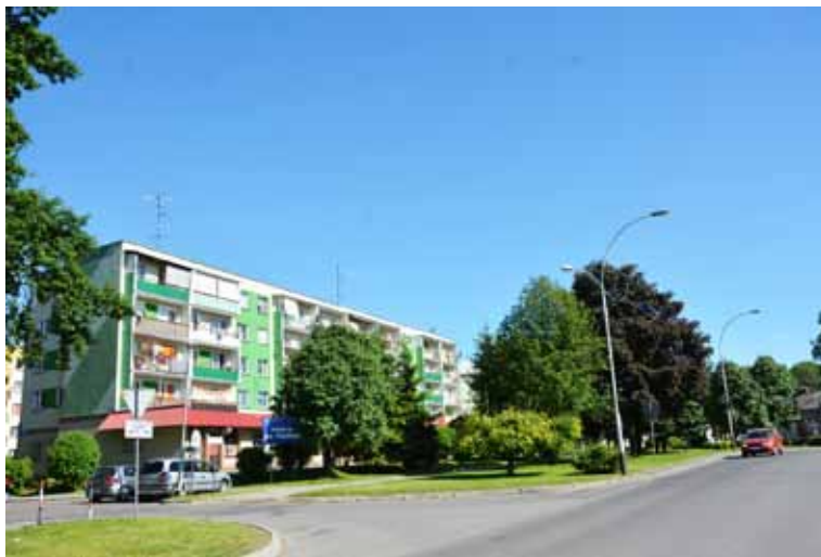
Parking ma powstać w miejscu drzew widocznych na zdjęciu.
