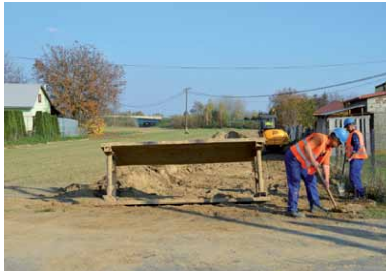
Wykopy trwają już przy ul. Piaskowej.
