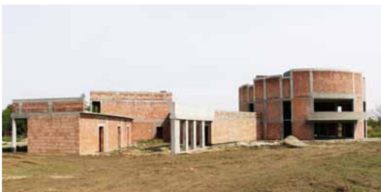
W tej chwili budynki są w stanie surowym.
